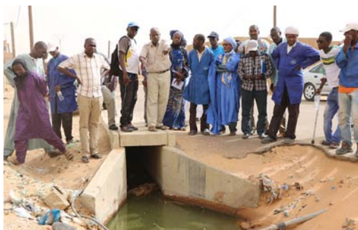
Échanges entre professionnels de l'assainissement sur le terrain, à Podor (Sénégal).
