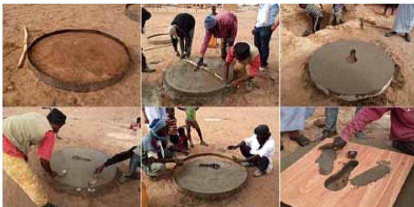
Différentes étapes de construction d'une dalle Sanplat par des maçons en Mauritanie.
