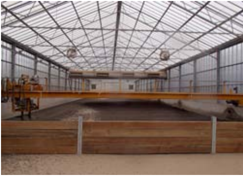
Serre de séchage solaire à l'Étang-Salé, La Réunion (France).
