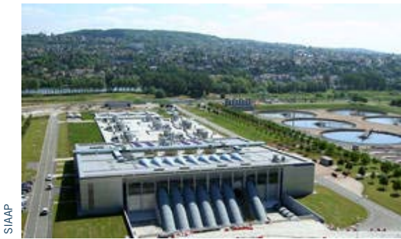
Usine de traitement Seine Aval (France).
