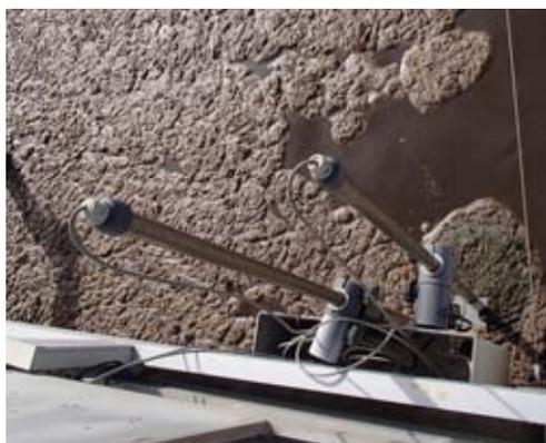
Dysfonctionnements de solution de traitement : invasion d'un bassin d'aération par les flottants.
